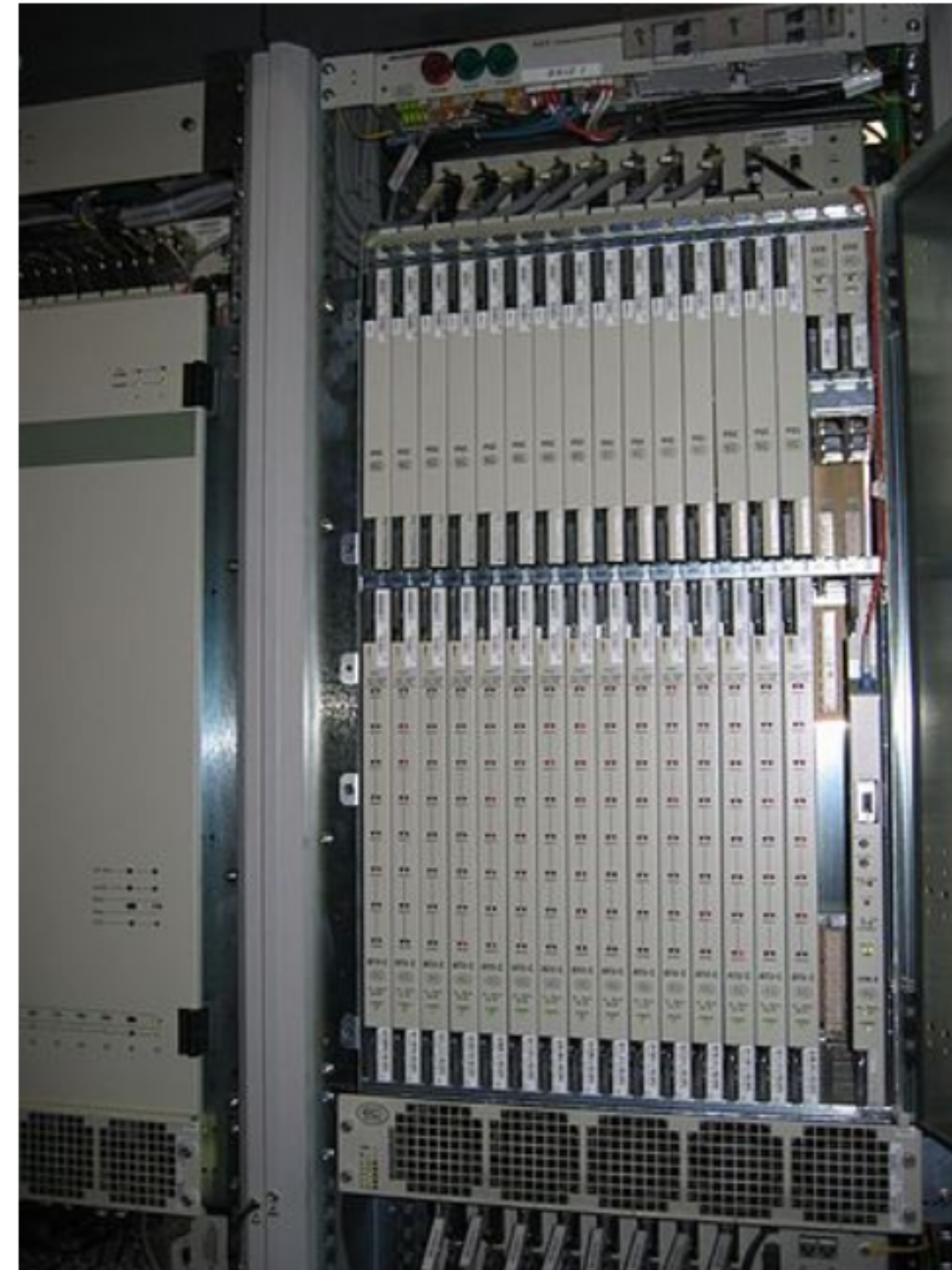
Foto de un DSLAM en una Central Telefónica
